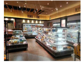
スーパーマルシン (6月、冷設工事)
